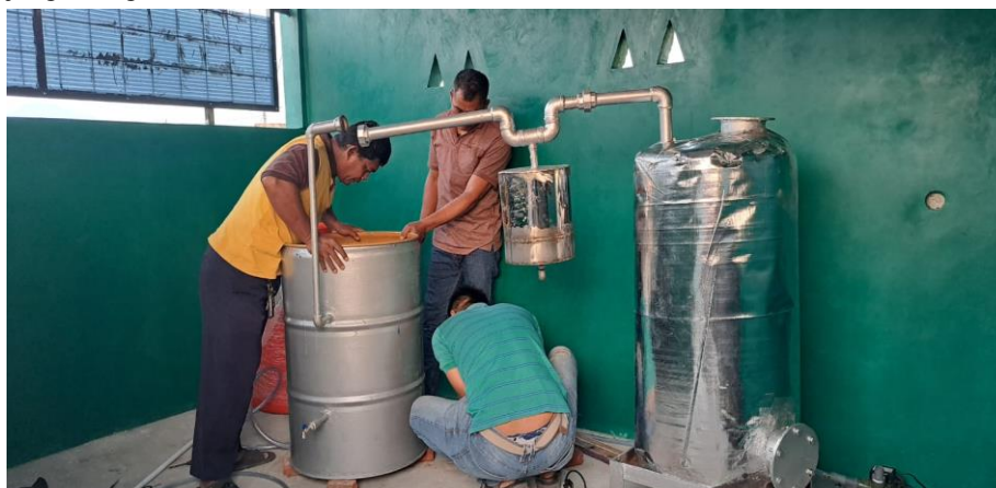
Gambar 3. Proses Instalasi Pirolisis di Desa Bojong Soang
