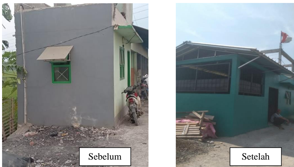
Gambar 4 Kondisi lokasi Bank Sampah sebelum dan setelah didirikan bank Sampah
